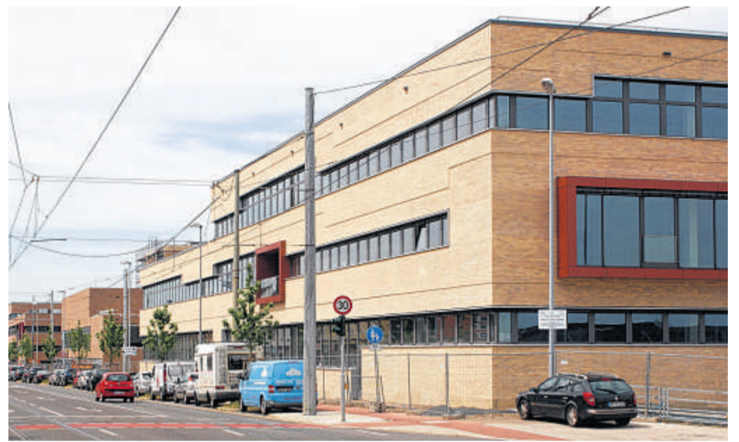
Das Gerüst ist weg. Nun ist die Hochschule gut zu erkennen.
